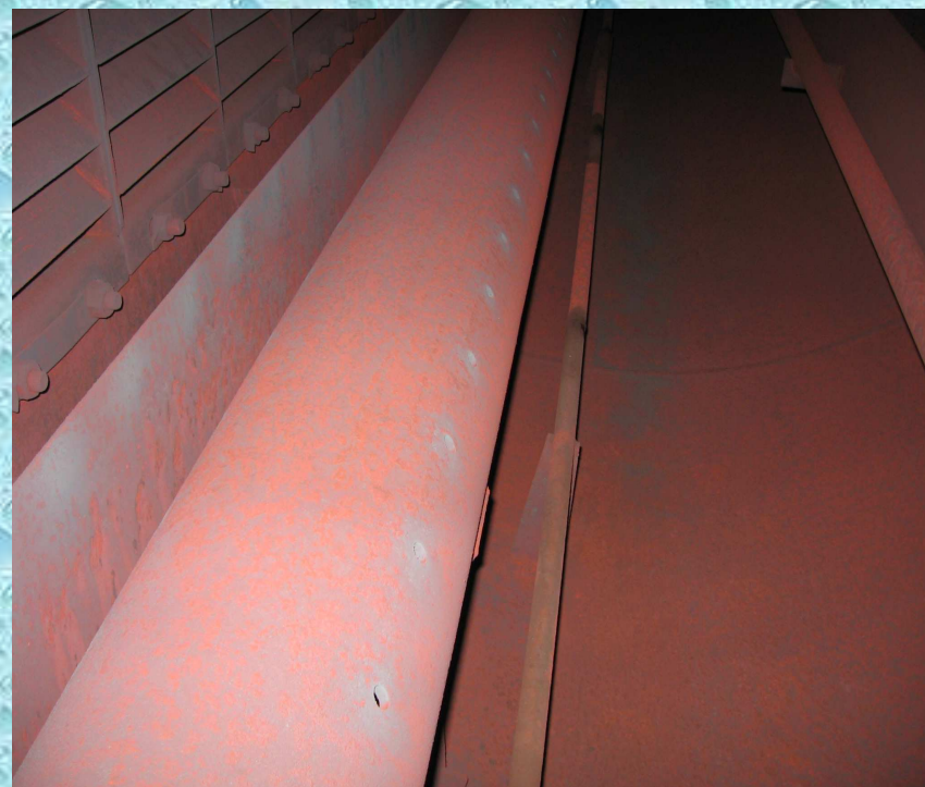
Внешний вид барабана после увеличения дозировки хеламина
